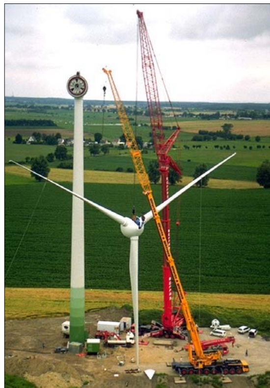
Abb. 4: Windkraftanlage (1,5 MW) mit 100 m Gesamthöhe im Bau.
